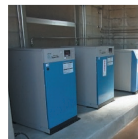
空気供給設備
