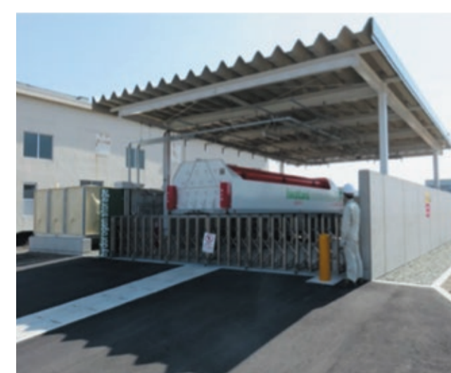
大容量水素供給設備
