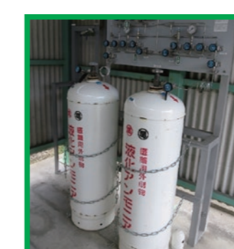
アンモニア供給設備 貯蔵量:50kg×2
